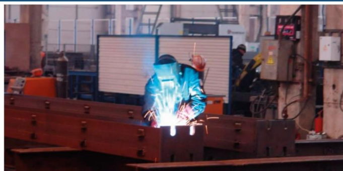
СБОРКА И СВАРКА
